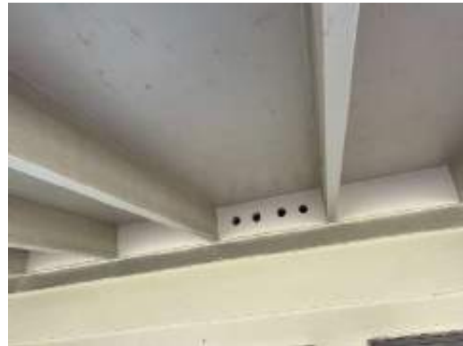
Soffit Vent
