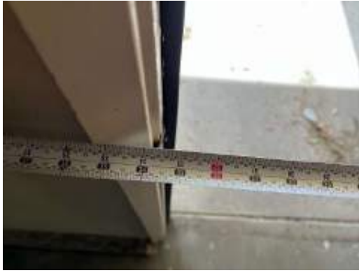
Laundry Room Door Width
