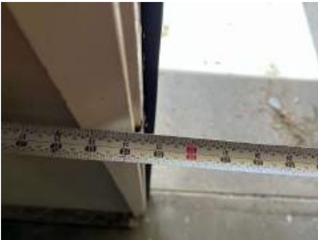
139. Laundry Room Door Width
